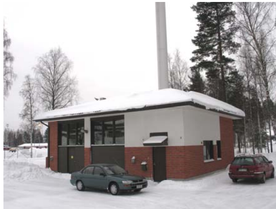
Ruokolahden kunnan lämpökeskuksen kokonaisteho on 2+4 MW ja polttoaineena käytetään sekä öljyä että maakaasua.
